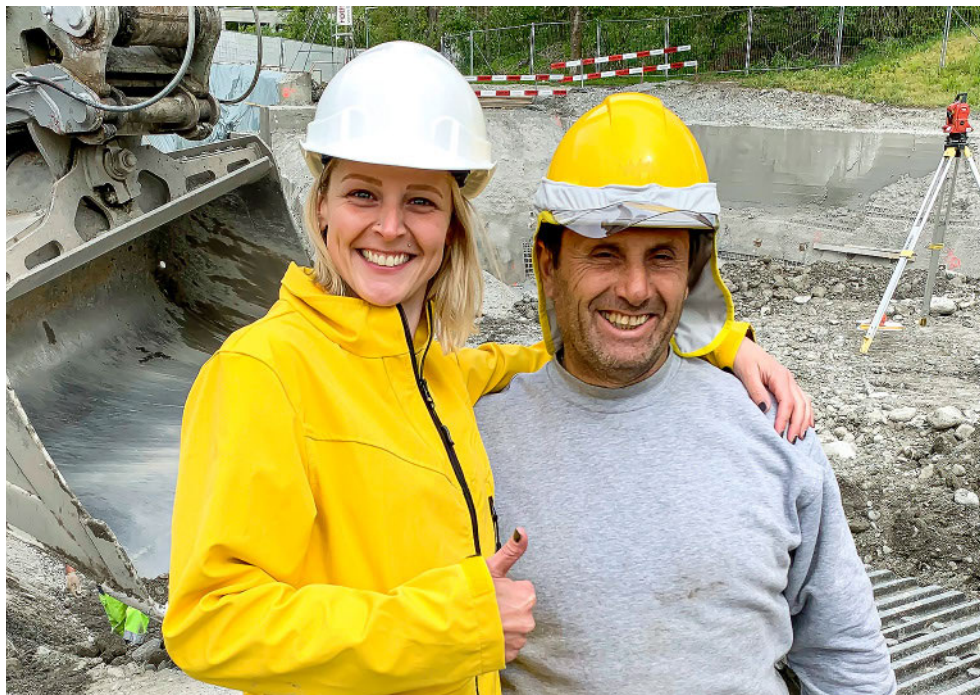
Protege-te do sol! A nova proteção do pescoço na construção civil é simples e adequada.
